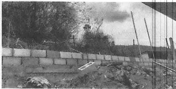
Foto 2: Colocación de block con fundición de cemento
